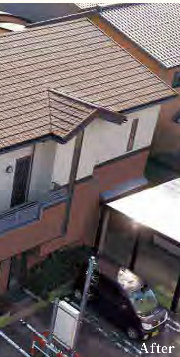
「デクラ屋根システム」施工後
