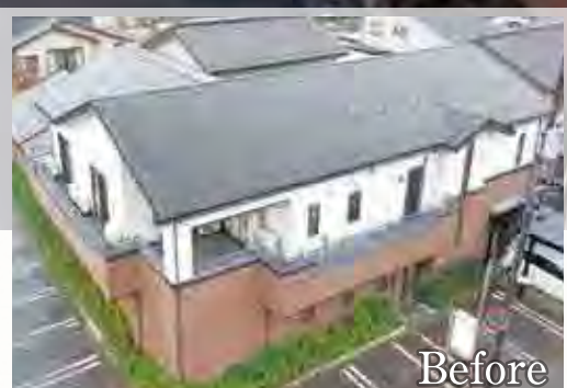
「デクラ屋根システム」施工前
