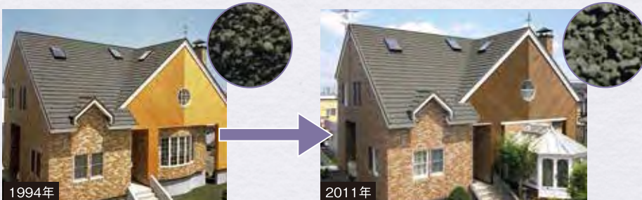
デクラ屋根システムの経年変化
