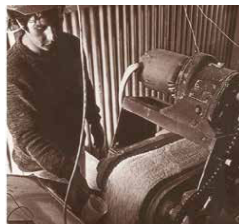
1974年 屋根材表面の石粒用粉砕機
